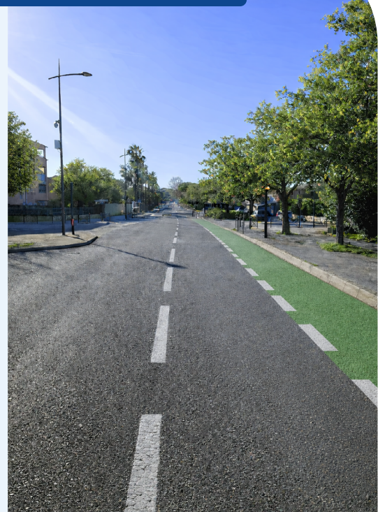
Rénovation route chemin de l'Evescat
